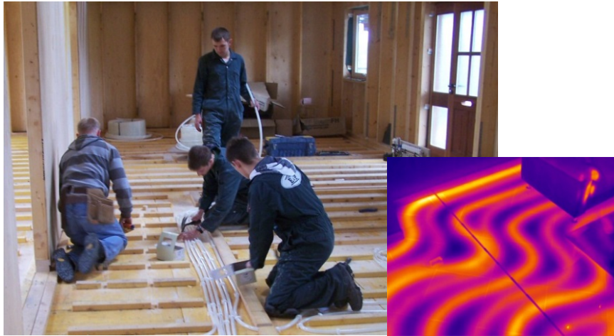
Монтажники ОВК / Охолодження
